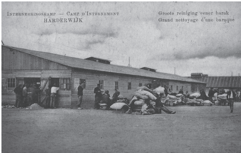
Afb. 4. Belgische soldaten in het interneringskamp in Harderwijk (Gelderland, Nederland). (Privécollectie auteur)
