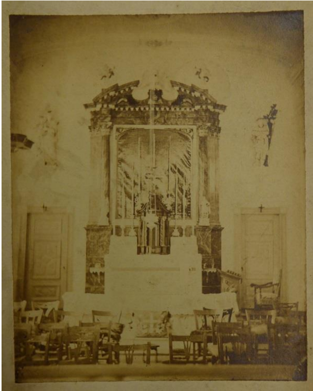
Afb. 15. Foto interieur (1860-1870) voormalige OKK te Enkhuizen, Utrecht, MCC, OKM f156
