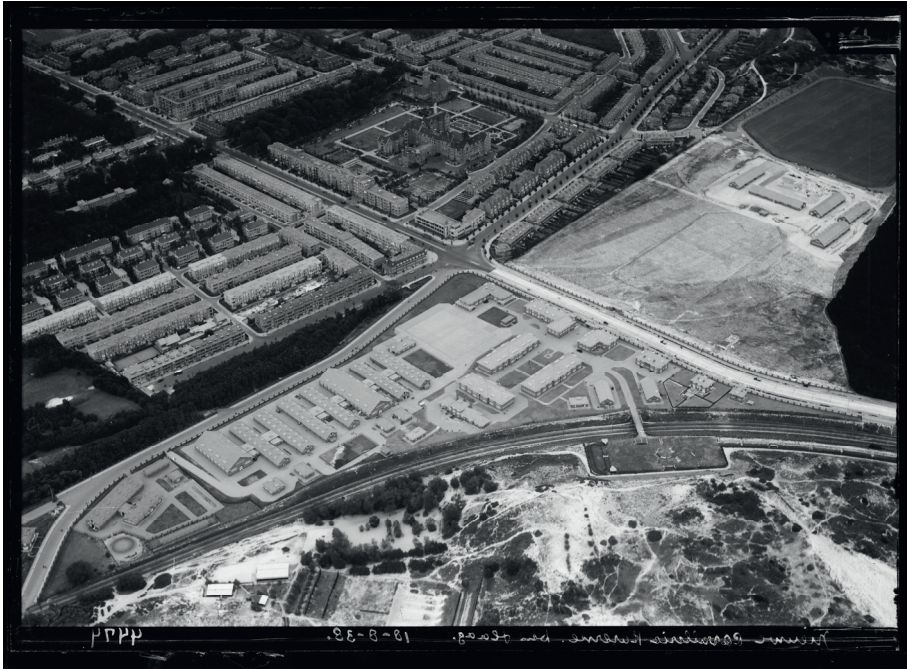
Afb. 23. Het Van Alkemadecomplex in aanbouw, 1938.
