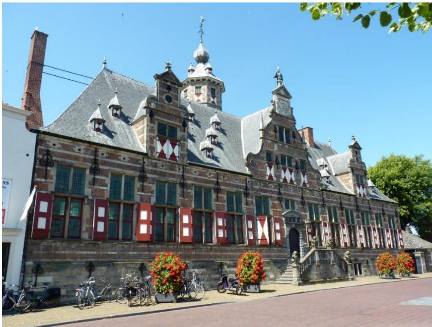
Afb. VI.3. De Kloveniersdoelen (1607) te Middelburg: vanaf 1985 het Centrum Nieuwe muziek voor NMZ. 894
