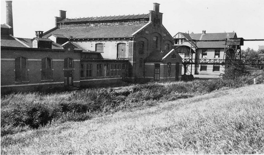
Afbeelding 15 Foto van de voormalige gasfabriek en het toekomstig terrein voor het IKO, aan de Ringdijk in Amsterdam.
