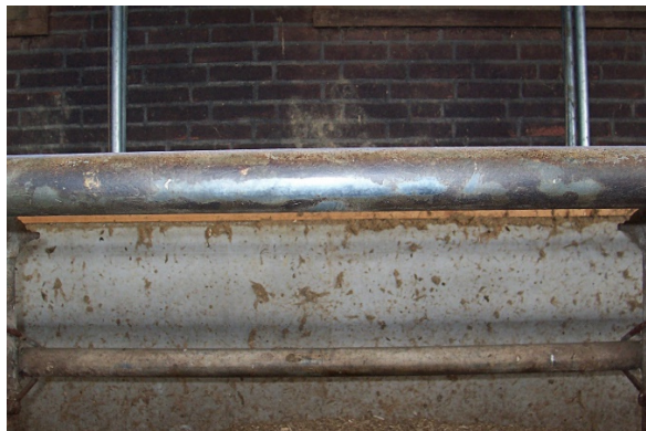
Figura 3: Barra del cuello brillante de un cubículo debido al contacto frecuente con las vacas.
