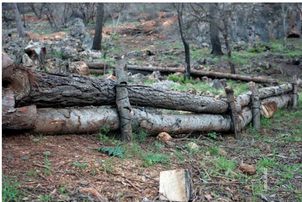
Tras un incendio son recomendables actuaciones para favorecer la regeneración. Albarradas de troncos para retener el suelo tras un incendio. Sierra de Cazorla (Jaén)
