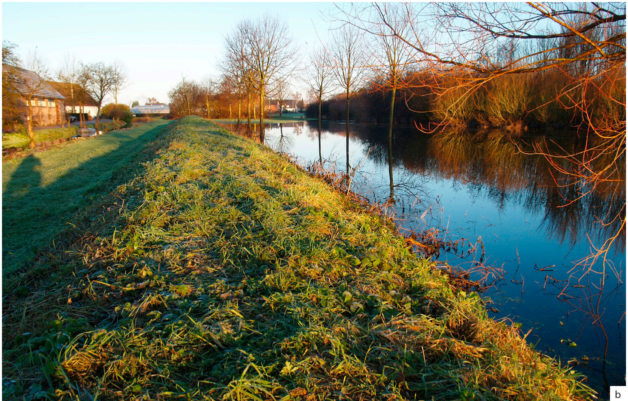
Figuur 7.14. b. Deel van een historische kade in het grensgebied van Lent en Doornik. Deze volgt niet het oude grensbeloop tussen beide dorpen, maar ligt op Doornikse grond. Links ligt een relict van de afwatering van een Lentse doorbraakkolk (de Kolk van Van Elferen). De kade beschermde het Doornikse land tegen het kwelwater dat vanuit de kolk toestroomde. Op de foto is te zien dat juist Lent voordeel ondervond van de kade, doordat deze verhoedde dat het Doornikse kwelwater naar het Lentse gebied stroomde.
