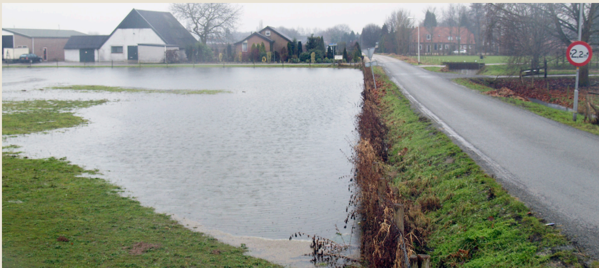
Figuur 7.2. Voorbeeld van een zijdewende in Doornenburg: de Landweer. Na de sluiting van de dijkkring bleven de wenden nog een waterkerende functie behouden, ditmaal als kweldijk en op den duur ook als compartimenteringsdijk voor waterberging.
