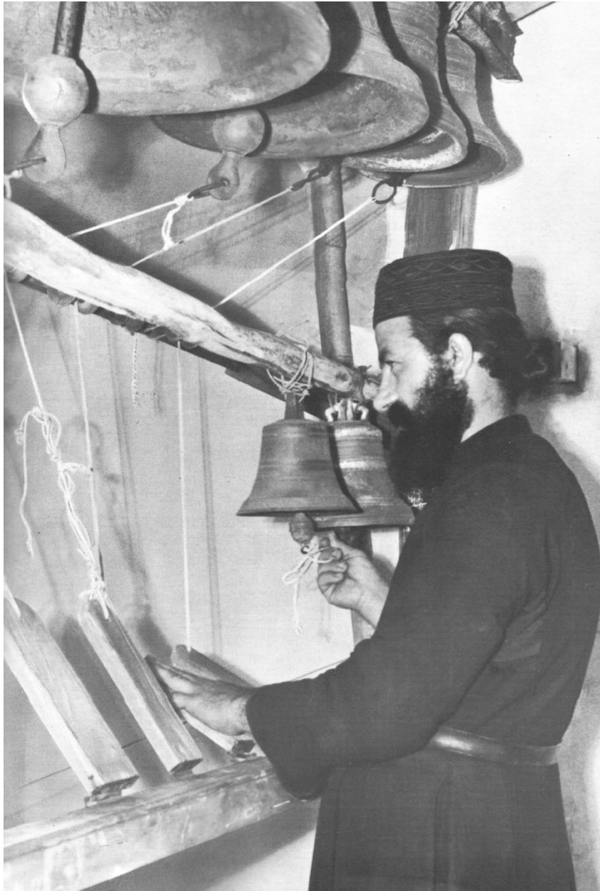
Afbeelding 51. Monnik Euthymios in het klooster van Katounakia op de Athosberg. De speler bespeelt de grotere klokken door met de linkerhand hefbomen naar omlaag te drukken. Op de achterkant van de balk op ooghoogte van de beieraar zijn katrollen bevestigd (Huber 1969, afb. 32 op p. 85).
