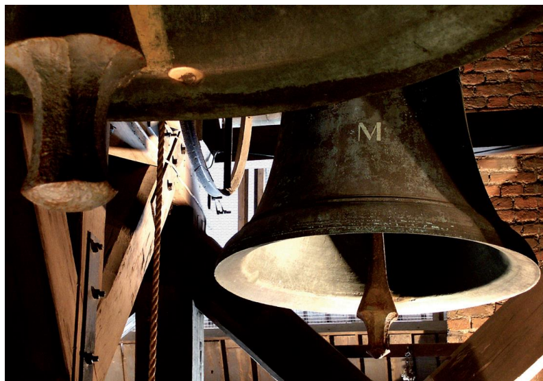
Afbeelding 38. Twee luidklokken van Geert van Wou in de Domtoren in Utrecht. Vooraan hangt Maria, achteraan Baptista. Op Baptista is op de slagring links een cirkelvormig beierspoor te zien.
