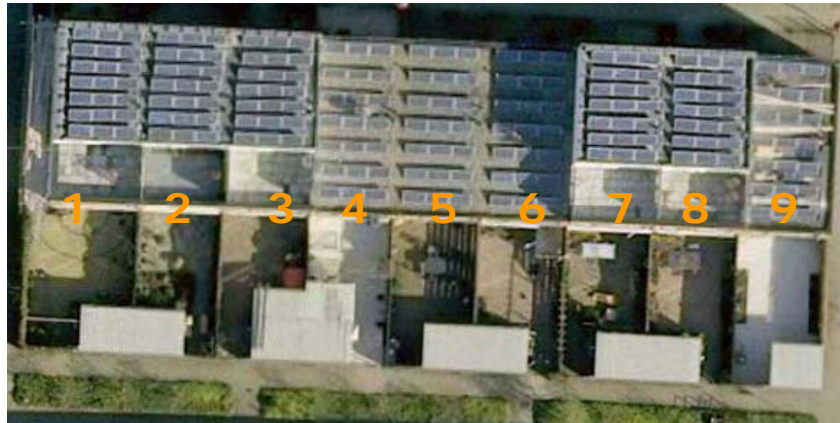
Figuur 3. Google Earth foto's, van voorjaar 2006. Systemen 4, 5, 6 en 9, zijn de oorspronkelijke. Bij systemen 1, 2, 3, 7 en 8 is een dakuitbouw gerealiseerd, dat door beschaduwing leidt tot een lagere opbrengst van het eigen systeem, maar ook tot schaduwverliezen van naastgelegen systemen.
