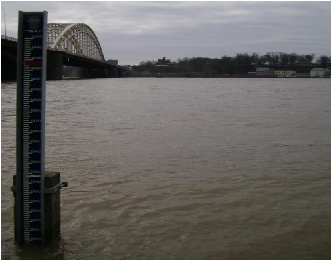
Foto 5: Waalbrug Nijmegen in (2010), voor aanvang dijkeruglegging Lent, tijdens normaal hoogwater. Foto: Willem Toonen, UU.
