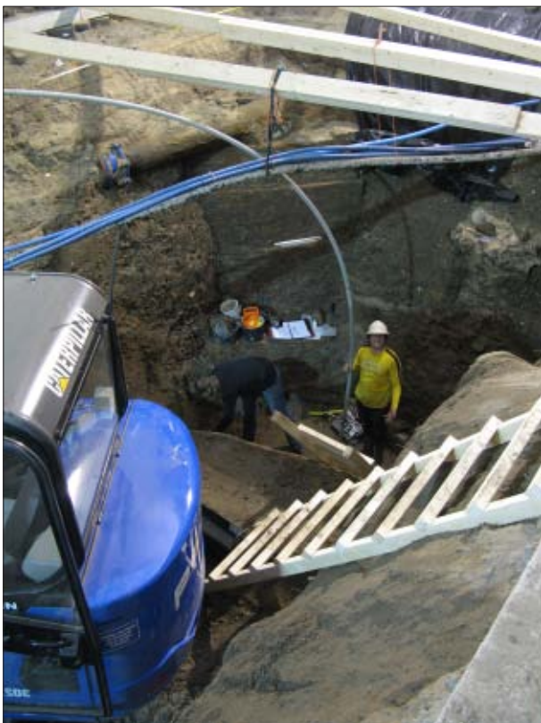
Afb. 2.4 Het zetten van de Van der Staaij-boring in de opgravingsput in 2011.
