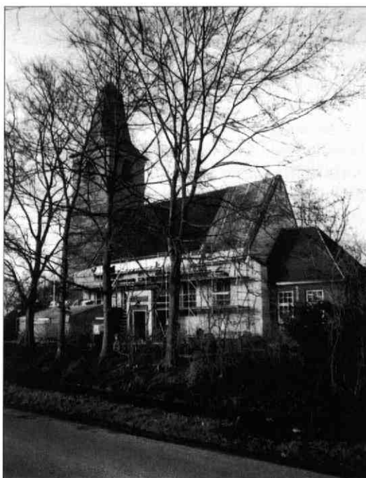
1 De kerk van Overlangbroek tijdens de restauratie 2000-2001, vanuit het zuiden gezien (Vlaardingebroek en Wevers, 2001)
