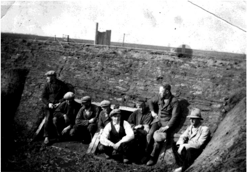
Bouw van de steenfabriek in 1934. Evert Kuijer (vijfde van links) werkte er na de bouw als voorman. Daarna werkte hij vanaf het begin in 1940 ongeveer 30 jaar bij de Ocrietfabriek. Hij kon thuis met recht zeggen: "ik heb de Ocrietfabriek gebouwd".
