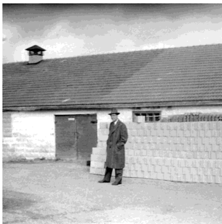
Directeur Van der Eerde staat trots voor één van de gebouwen, die door de acte van 30 juni 1939 zijn gekocht van tegel- en betonfabriek "De Eem".
