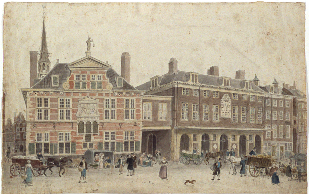
Afbeelding 6.36b. Het stadhuis van Rotterdam aan de Kaasmarkt. De ruimtes boven de naastgelegen kaasmarkt waren in de loop der tijd bij het stadhuis getrokken. [GAR CD 108-1]
