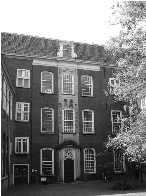
Afbeelding 7.7. Voorgevel van de in 1774 vernieuwde vleugel van het weeshuis aan de binnenplaats. Dit vormde ook de toegang tot de achtergelegen regentenvertrekken. Rondom het centrale venster op de eerste verdieping zijn de familiewapens aangebracht van de instellingsregenten. [Foto auteur]
