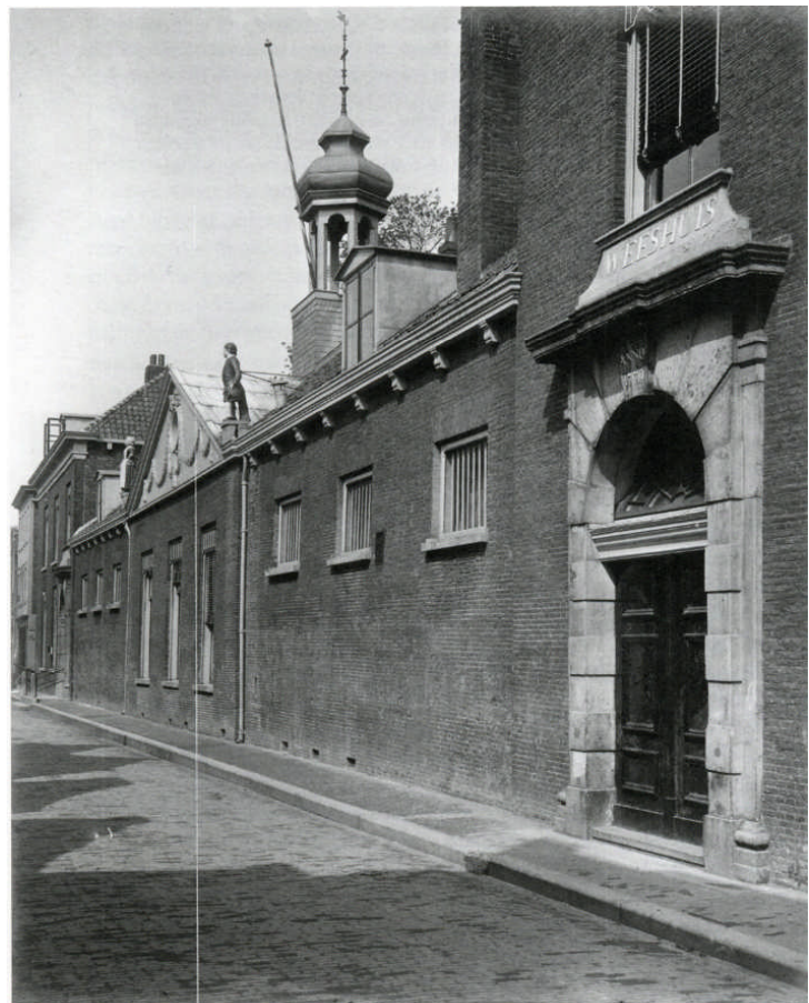
Afbeelding 7.10. De gevel van het weeshuis na de verbouwing van 1778. [Scan Van der Vlis 2005, p. 146]
