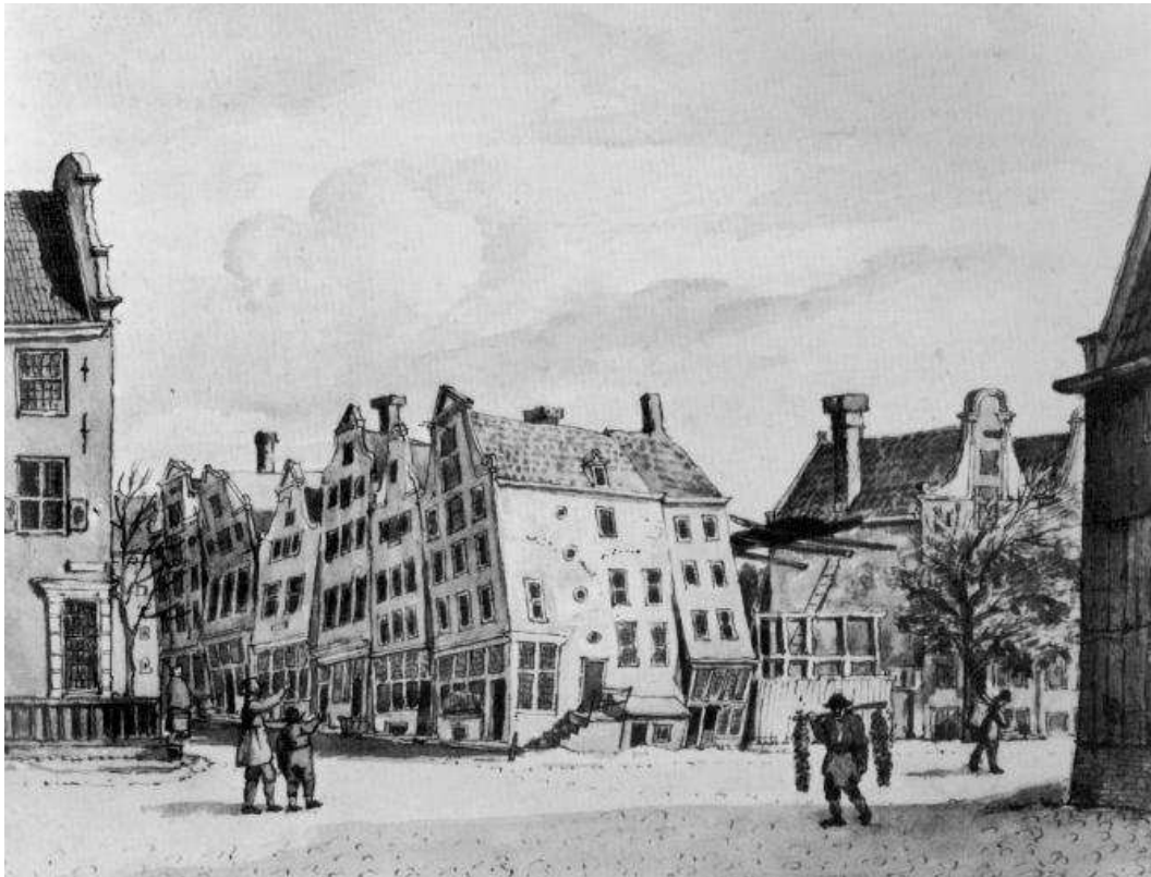
Afbeelding 8.3. G. Lamberts, de ingezakte huizen op de hoek van de Leidse straat en het Leidse plein in Amsterdam, 1806. [GAA]
