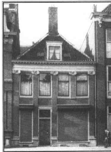
De voorgevel van Janskerkhof 11 tijdens de verbouwing (1922) en als Maison IPA in 1944 Foto's: Collectie beeldmateriaal HUA
