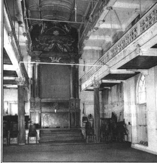
Interieur van de Gertrudiskapel voor de restauratie. Foto: GAU
