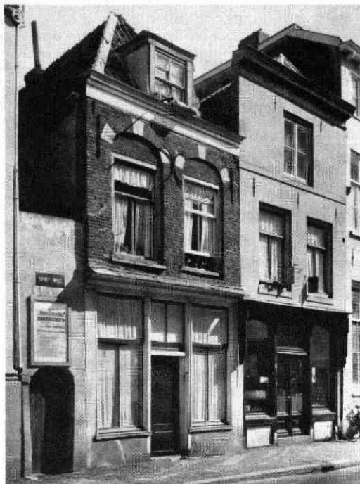
Afb. 238 Springweg 4 en 6. Voorgevels vóór 1968.
