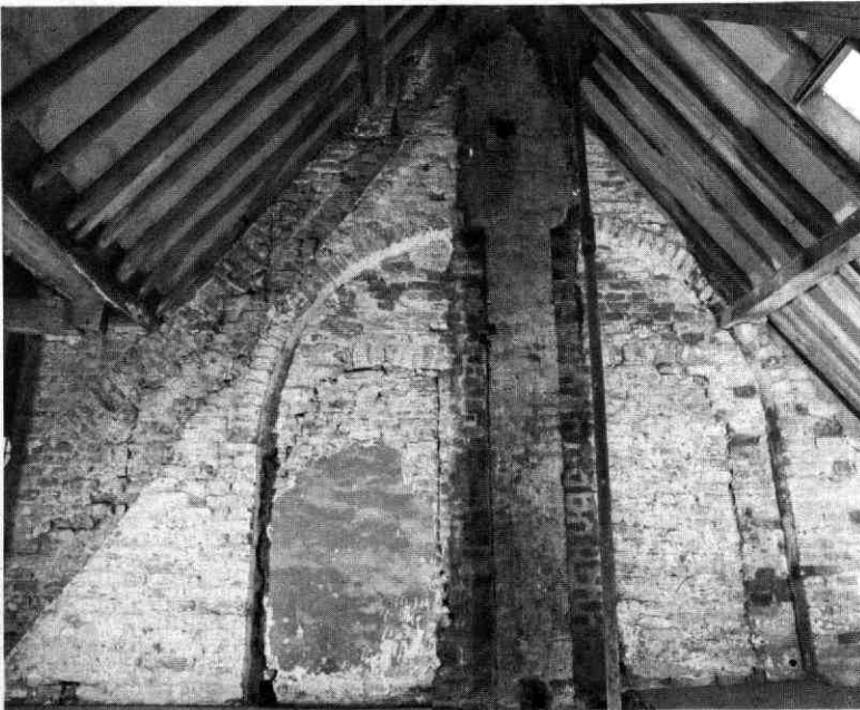
Afb. 98 Kromme Nieuwe Gracht 33. De top van de oostgevel. Duide-lijk is de dubbele spaarnis te zien met de sporen van zoldervensters en het balkgat bovenin van het blokkeel naar de haanhouten van de eerste 4 of 5 sporenparen.
