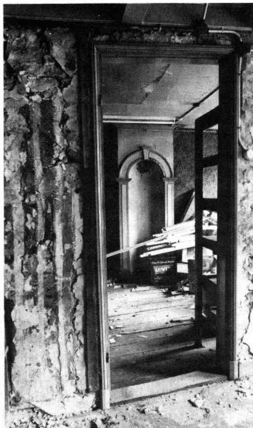
Afb. 109 Lange Elisabethstraat 13. Het schouwttje van 1824 en op de voorgrond links het „behang” uit dezelfde tijd: rode verfbanen op de gewitte muur.
