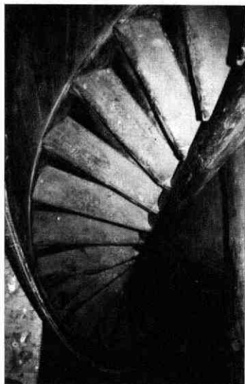
Afb. 174 Nicolaaskerkhof, Nicolaastoren. De spiltrap uit 1581. Foto's A. F. E. Kipp. A: Van bovenaf gezien. B: Detail van de bevestiging van de treden middels zwaluwstaarten, die met een spijker gezekerd zijn. C: De trap van onderen gezien.
