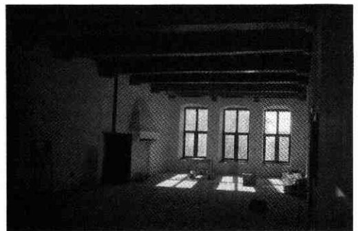
Afb. 189 Oude Gracht 99, Oudaen. De eerste verdieping van het hoofdhuys, naar achteren gezien. Duidelijk valt het kwaliteitsverschil op tussen de moerbalken van de (bewoonbare) achterkamer en die van de (zolderachtige) voorzaal.
