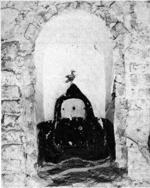
Afb. 101 Kromme Nieuwe Gracht 33. De lavabo-nis geopend met onderin de resten van de waterbak met afvoer. De bak was gemaakt van twee stukken zandsteen die met krammen waterdicht waren verbonden. In de achterwand het tufstenen nisje, bebroond met een 16-eeuwse vogel.
