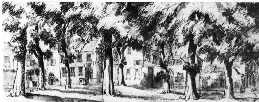
Afb. 81 Korte Nieuwstraat 2 en 4; Trans 2 en 4. Detail van een tekening van het Domplein en het Oudmunsterkerkhof. J. de Beijer, 1745 (Kon. Huis Archief). 1: Korte Nieuwstraat 4; 2: Korte Nieuwstraat 2; 3: Een van de kruiskozijnen in de middeleeuwse voorgevel van Korte Nieuwstraat 2, uitkijkend op het Oudmunsterkerkhof; 4: Het „comptoirken en camertgen" van de heer Van Ewijck (1646); 5: het toegangspoortje naar het huis van de heer Van Ewijck; 6: Huizen ter plaatse van het huidige Universiteitsgebouw (Domplein 29); 7: Toegang tot de Kloostergang, ter plaatse van het huidige St. Maartenspoortje; 8: Scheidingsmuur tussen de immuniteiten van Dom en Oudmunster.
