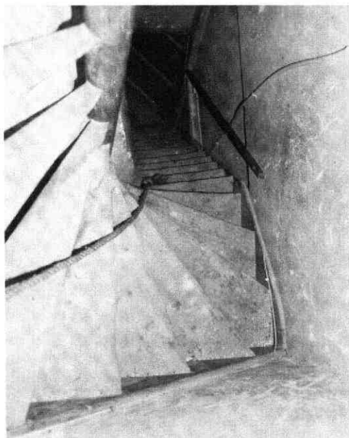
Afb. 11 Achter Clarenburg 5. Trapje van de begane grond naar zolder. Foto Bart Klück. Waar het rechte gedeelte overgaat in een spiltrapje wordt de klim zó steil, dat een touw onontbeerlijk is.
