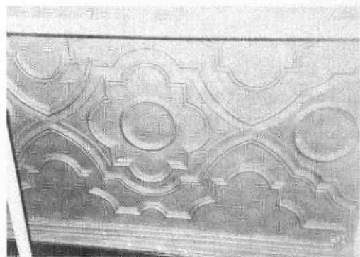
Afb. 78 Keizerstraat 35. Een voorbeeld van het in de tekst beschreven stucplafond, gezien in het voormalige Cellebroedersklooster te Mechelen (B). Foto Jan van der Hoeve.
