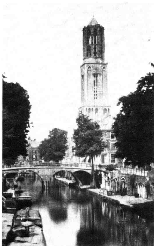
Afb. 214 Oude Gracht 218, Rodenburg. Gezicht op de Hamburgerbrug en de 17e-eeuwse huizen op de kelders van het huis Rodenburg (deels verstopt achter de bomen), voor 1867. Foto A. Braun (GAU/TA Oudegracht tussen Hamburgerbrug en Weesbrug c. 1870 (1))
