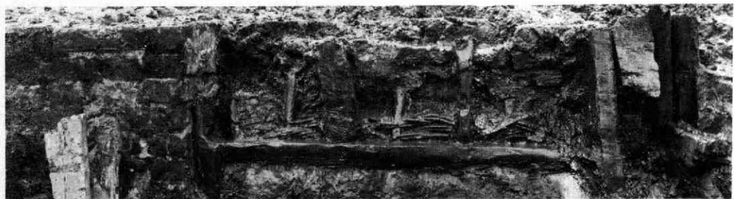
Afb. 40 Boterstraat. Stuk vakwerkbouw dat in het profiel bewaard is gebleven. Links hiervan is te zien hoe de latere stenen muur de hoekverbinding tussen vakwerk en vlechtwerkbalk heeft vernield.
