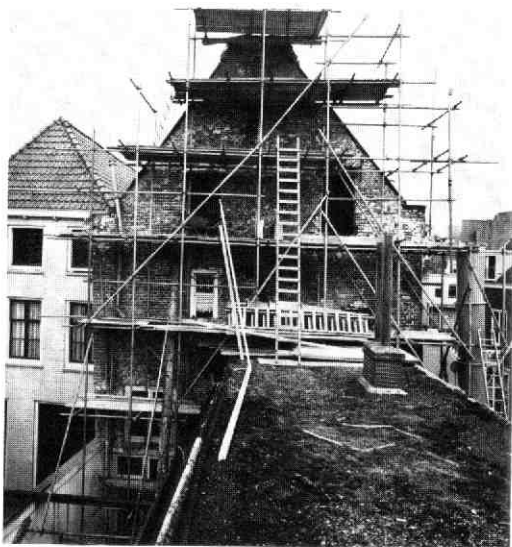
Afb. 91 Oude Gracht 319-321. De in de 17-eeuw gewijzigde achtergevel van het oorspronkelijk 14-eeuwse huis.
