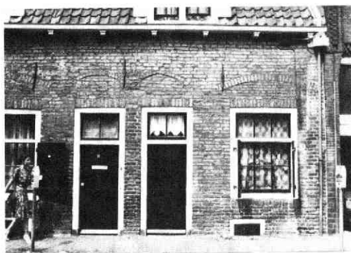
Afb. 63 Jansveld 4-20. Detail van de gevel aan het Jansveld met sporen van ingangsnissen en segmentbogen van brede vensters. Foto B. J. M. Klück.
