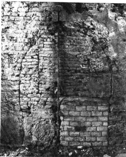
Afb. 27 Bemuurde Weerd OZ 23. De in de noordwand aangetroffen rondboog-opening.
