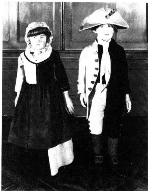
Afb. 111 Springweg 102-102A. Poorthuis. Poppen, die kinderen uit het Burgerweeshuis in laat 18e-eeuwse kleding voorstellen. Deze kleding bevat waardevolle, aanvullende informatie bij het weer aanbrengen van de oorspronkelijke kleuren en kleurverdeling op het reliëf van de poort. De poppen worden bewaard in het Evert Zoudenbalch-huis, Nieuwe Gracht 98.
