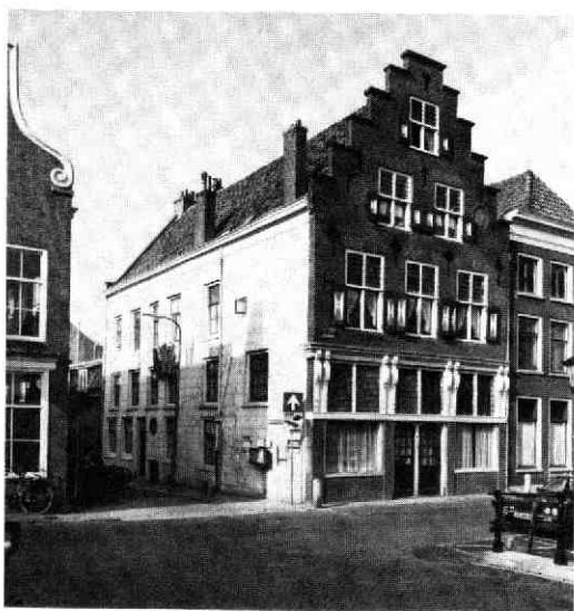
Afb. 90 Oude Gracht 319-321. Het huis met de in 1936 gerestaureerde 17e-eeuwse voorgevel gezien vanuit het zuidoosten.
