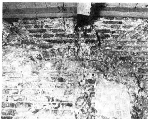
Afb. 106 Springweg 102-102A. Poorthuis. Detail van de zuidwand op de verdieping met vensterboog en daarboven een fragment van de geschilderde zonnwijzer.
