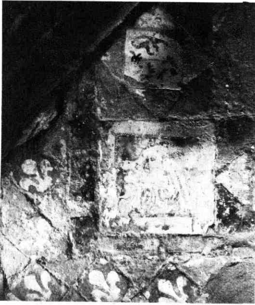
Afb. 40 Domplein. Domkerk. Tegels met tinglazuur en met slibversiering. Foto F. Kneefel. Onder: rode tegeltjes met gele fleur-de-lis in slib. Midden: tegel met tinglazuur en een manskop. Boven: tegel met tinglazuur en een klimmende leeuw.
