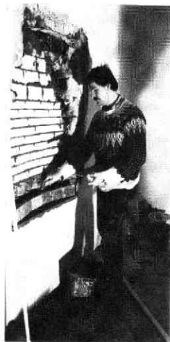
Afb. 31 Bemuurde Weerd OZ 23. De stookplaats. a: de stookplaats met haardstenen zoals hij aangetroffen werd. b: de gerestaureerde haardstenen worden door J. van Kreuningen teruggeplaatst (foto B. J. M. Klück). c: de gerestaureerde stookplaats met haardstenen.
