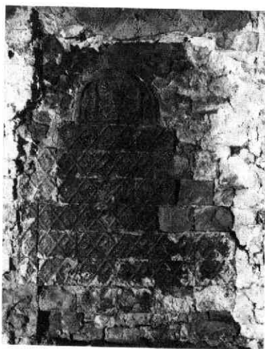
Afb. 31 Bemuurde Weerd OZ 23. De stookplaats. a: de stookplaats met haardstenen zoals hij aangetroffen werd. b: de gerestaureerde haardstenen worden door J. van Kreuningen teruggeplaatst (foto B. J. M. Klück). c: de gerestaureerde stookplaats met haardstenen.
