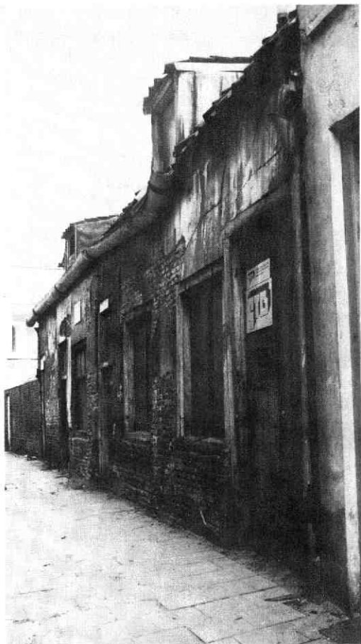
Afb. 7 Abraham Dolesteeg 11-17. De voorgevel van 11-17 vóór de restauratie.
