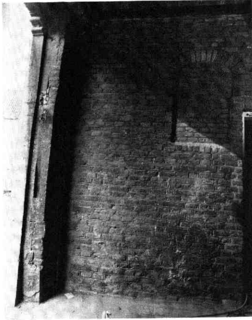
Afb. 109 Springweg 102-102A. Poorthuis. Detail van de noordwand met dichtgemetseld venster en, links, de zijpost van de hardstenen poort met een sleuf voor een sluitbalk.
