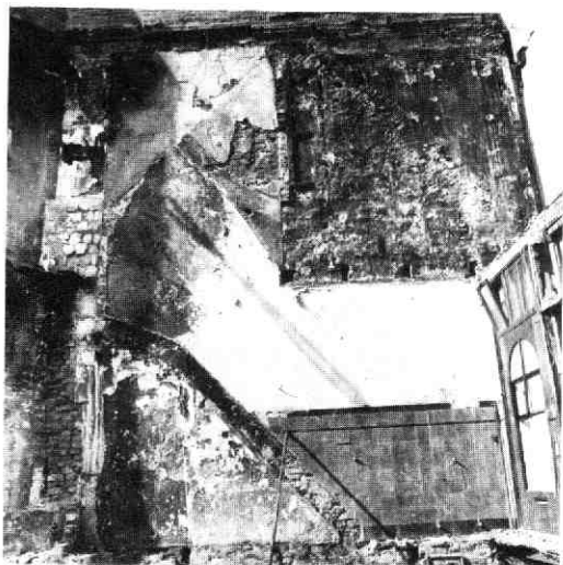
Afb. 35 Biltstraat 57-59. De na de brand vrijgekomen 17e-eeuwse eindgevel in de westmuur van Biltstraat 57.
