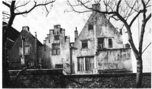
Afb. 121 Oude Gracht 242-244, 260-262-264, 284. De middeleeuwse achtergevels van de huizen 244, 242 en 240, met aanduiding van de contour van de gekanteelde trapgevelvorm van nr. 242.
