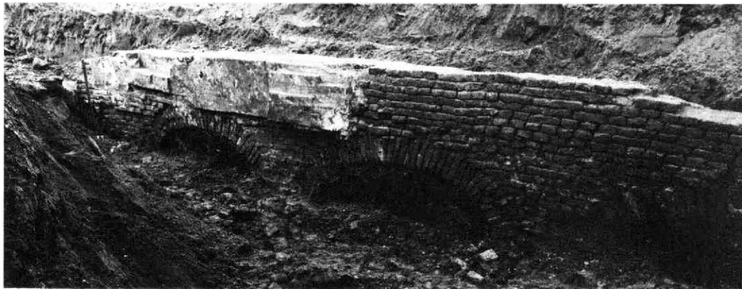
Afb. 58 Korte Nieuwstraat. De westelijke immunitetsmuur van de Paulusabdij, gezien naar het noordoosten. Duidelijk zichtbaar zijn de spaarbogen op poeren die in de dichtgegooidde sloot zijn ingegraven.
