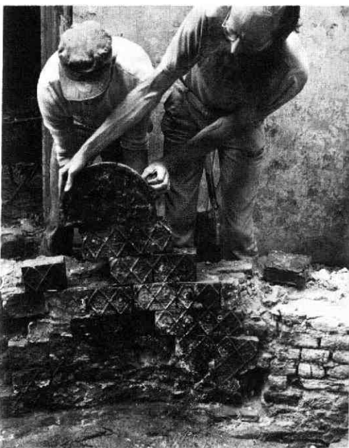
Afb. 179 Zilverstraat 14. Stookwand met haardstenen, die oorspronkelijk toebehoort heeft aan het achterhuis van Zilverstraat 12.
