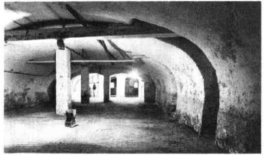
Afb. 132 Oude Gracht 270. De kelder naar het westen (werfkelder) gezien. Vooraan rechts een doorgang naar de kelder van de in de 18e eeuw vervangen „Steenen Kamer“. De zware balk is een overblijfsel van de brouwerij „De Witte Leeuw“.
