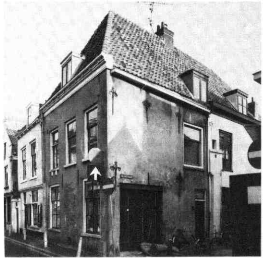
Afb. 138 Pauwstraat 30. Overzicht naar het noord-oosten. Het eerste anker van de verdieping is in de 19e eeuw herplaatst.
