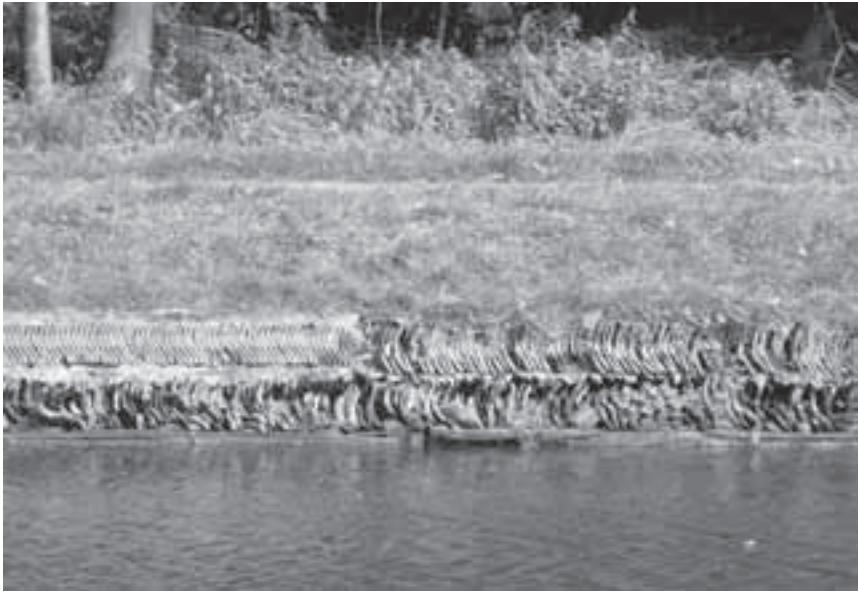
Afb. 1. Beschoeiing langs het jaagpad in Maarssen (ter hoogte van Doornburgh). (Foto auteurs)
