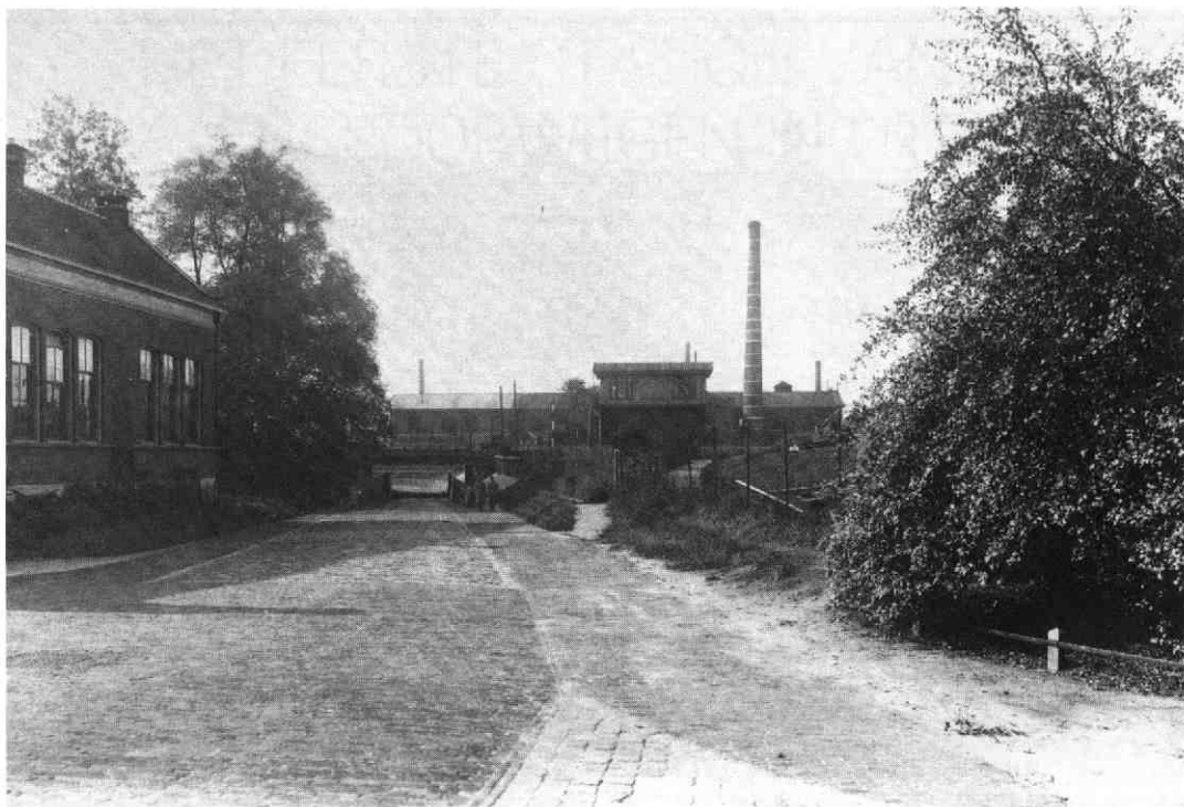
Gezicht op de tunneldoorgang „Uit en In“ vanuit het noordoosten; links een gedeelte van de school aan de Laan van Puntenburg, 1935. GAU Top.-Hist. Atlas TA Uit en In, 1935.
