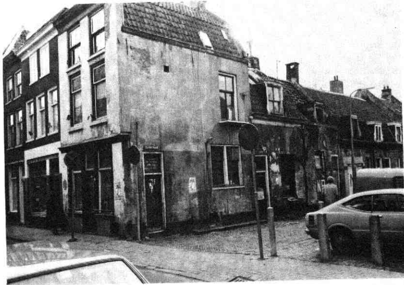
Afb. 1. Voor de restauratie.
