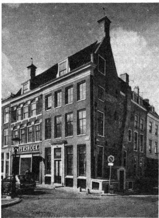
Oudegracht 279 na restauratie.
