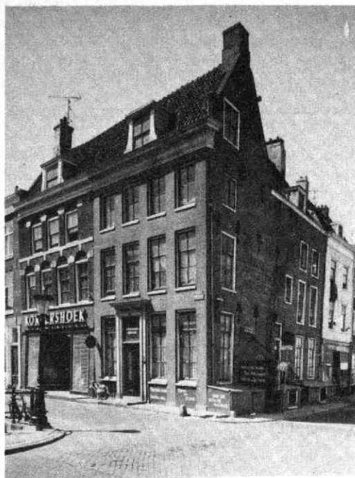
Oudegracht 279 vóór restauratie.
