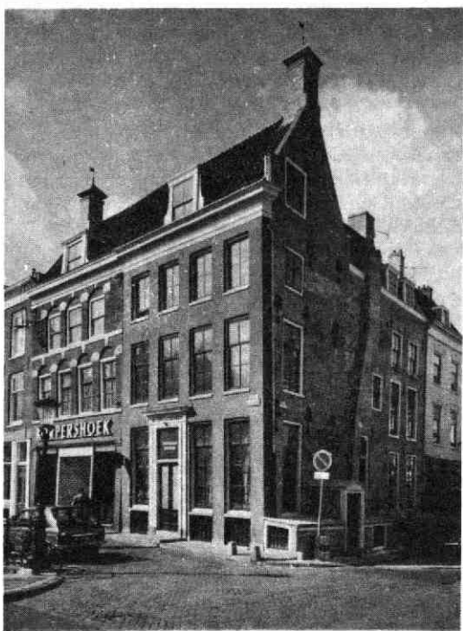
Oudegracht 279 na restauratie.
