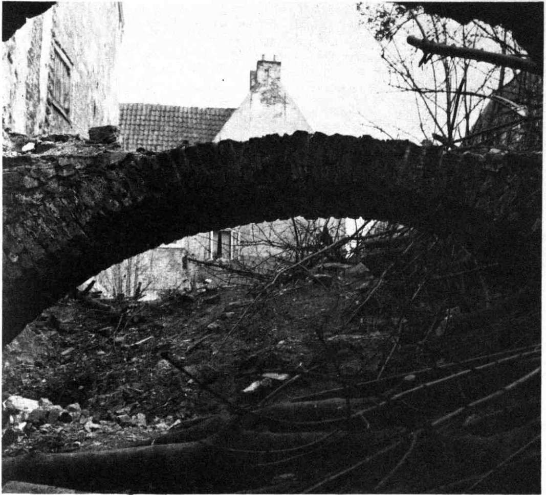
Boog onder Kromme Nieuwegracht 70, gezien vanuit de werfkelder, maart 1954. Op de achtergrond Jeruzalemstraat 8 (foto auteur).
