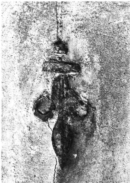
Muuranker in de Keizerstraat.
