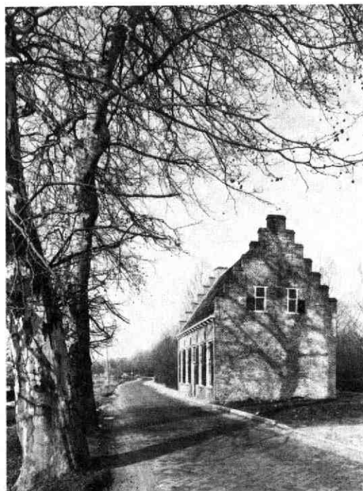
Het gerestaureerde huis Jagerskade 13-14 (Foto: Gemeentelijke Fotodienst)
