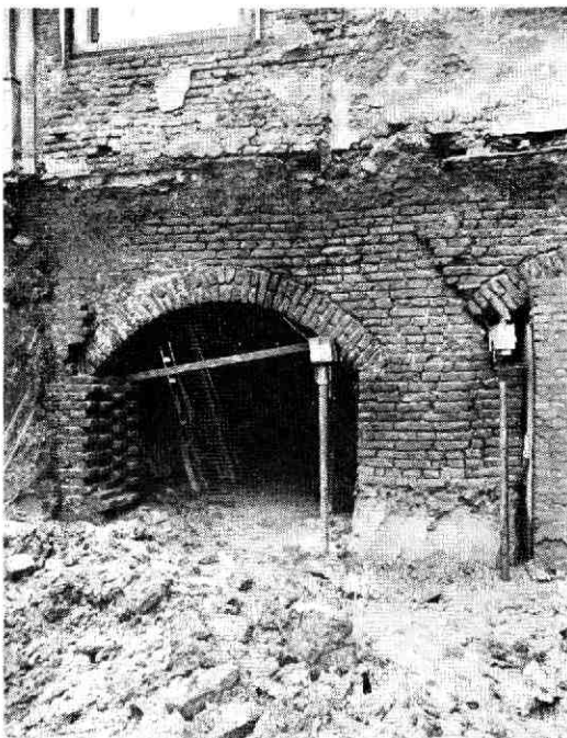
Afb. 1. De muur links van de boog eindigt in een zgn. staande tand.
