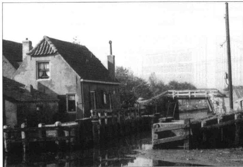
De sluis aan de Stadsdam.
