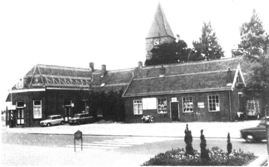
11. De zuidzijde van Het Oude Raadhuis met het vroegere koetshuis, nu schilderswerkplaats van A. Hoogstraten, vlak voor de afbraak.
