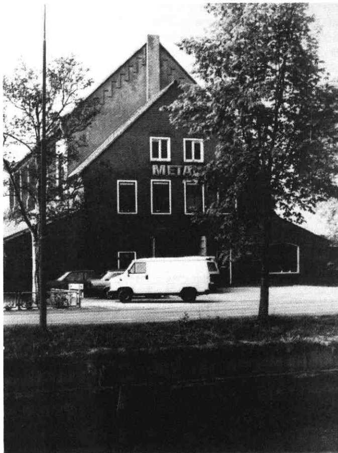
4. Het huidige aanzicht van de voormalige R.K. kerk aan de Rijksstraatweg vanuit het noordoosten
