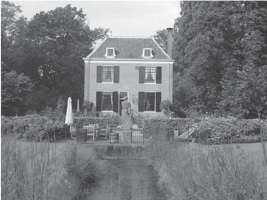
Bijdorf, gezien vanuit de tuin aan de achterzijde.
