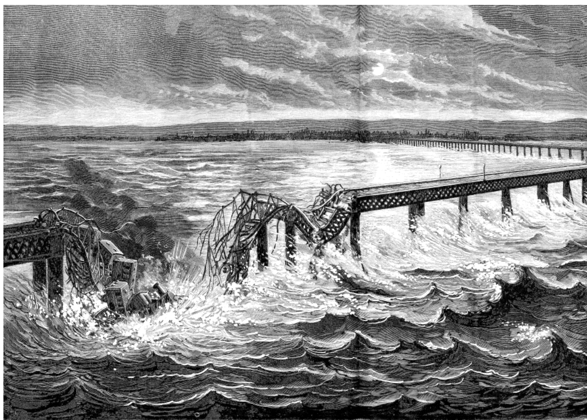
Afb. 3: Een trein rijdt in het gat van de brug over de Tay. De Hollandsche Illustratie 30, 1880.
