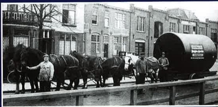
Een verwarmingsketel van Huygen & Wessel wordt door de firma Van den Hoek met paardentractie naar het station vervoerd. De foto is genomen aan de Nijverheidsweg, vanaf de spoorlijn. Circa 1922-1929.
