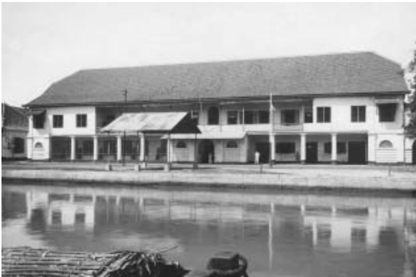
Het gebouw van de Factorij aan de Kali Besar in Batavia in 1915.
