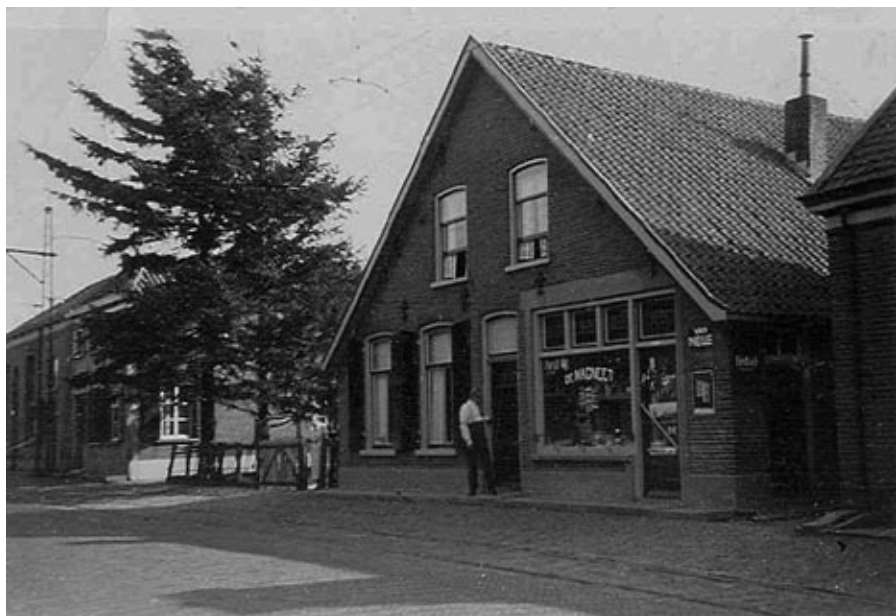
Rijksstraatweg 66 Elst, de kruidenierswinkel van Klaas Vermeer was het 'hoofdkwartier' van de KP in de laatste oorlogsjaren. Thans helaas afgebroken (foto coll. mevr. W.H.M. Sabel-Vermeer)
