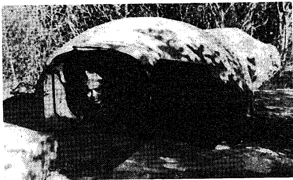
Een van de kazematten langs de Grift, Rhenen, juni 1940.
