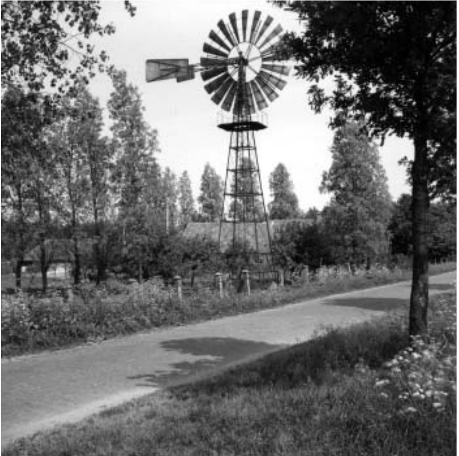
Derde watermolen, gezien vanuit het zuiden. Deze molen was gelegen tussen Meentweg 113A en Meentweg 115. Op de achtergrond is de boerderij Meentweg 115 zichtbaar.
