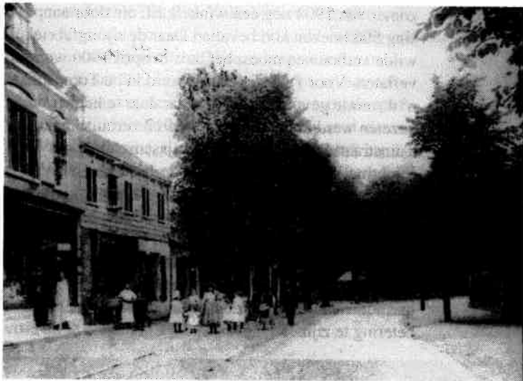
Links de kruidenierszaak van de heer Radix waarin eerst Gerrit van Santen woonde en waar nu de zaak van de heer Witteman is.
