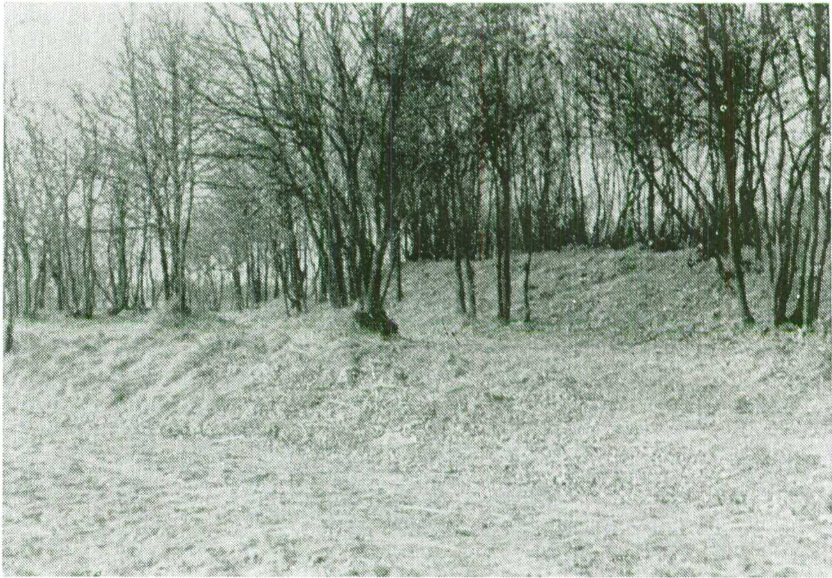
Noordelijke wal van het fort aan de Buursteeg
