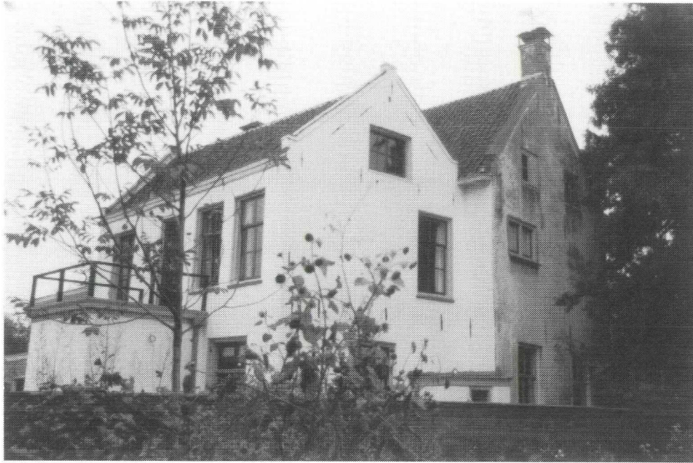
Afb. 2. Het huis Vecht en Dam gezien vanuit het zuidwesten. Het jongere achterhuis springt 1 meter in en de zuidmuur staat niet loodrecht op het oudere voorhuis. (Foto H. van Walderveen, 1996, in Foto-archief Historische Kring Breukelen.)
