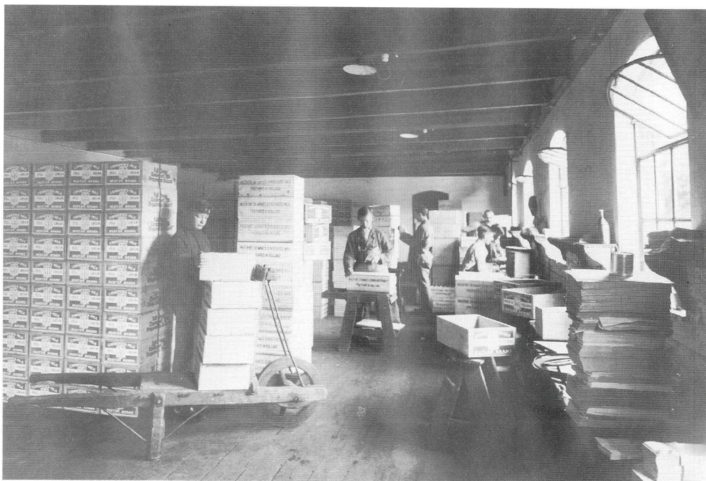
Afb. 5. De kistenmakerij uit begin jaren twintig. Het hout kwam op maat in dunne plankjes aan en werd hier in elkaar getimmerd. De kisten waarin de condens werd geëxporteerd, werden eerst voor intern transport gebruikt om de ongevolde blikjes te vervoeren. Er konden 48 blikjes van 14 oz. in. Voor de blikjes van 14 1 / 2 oz. (tins) was de hoogte van de kist daarop aangepast.
