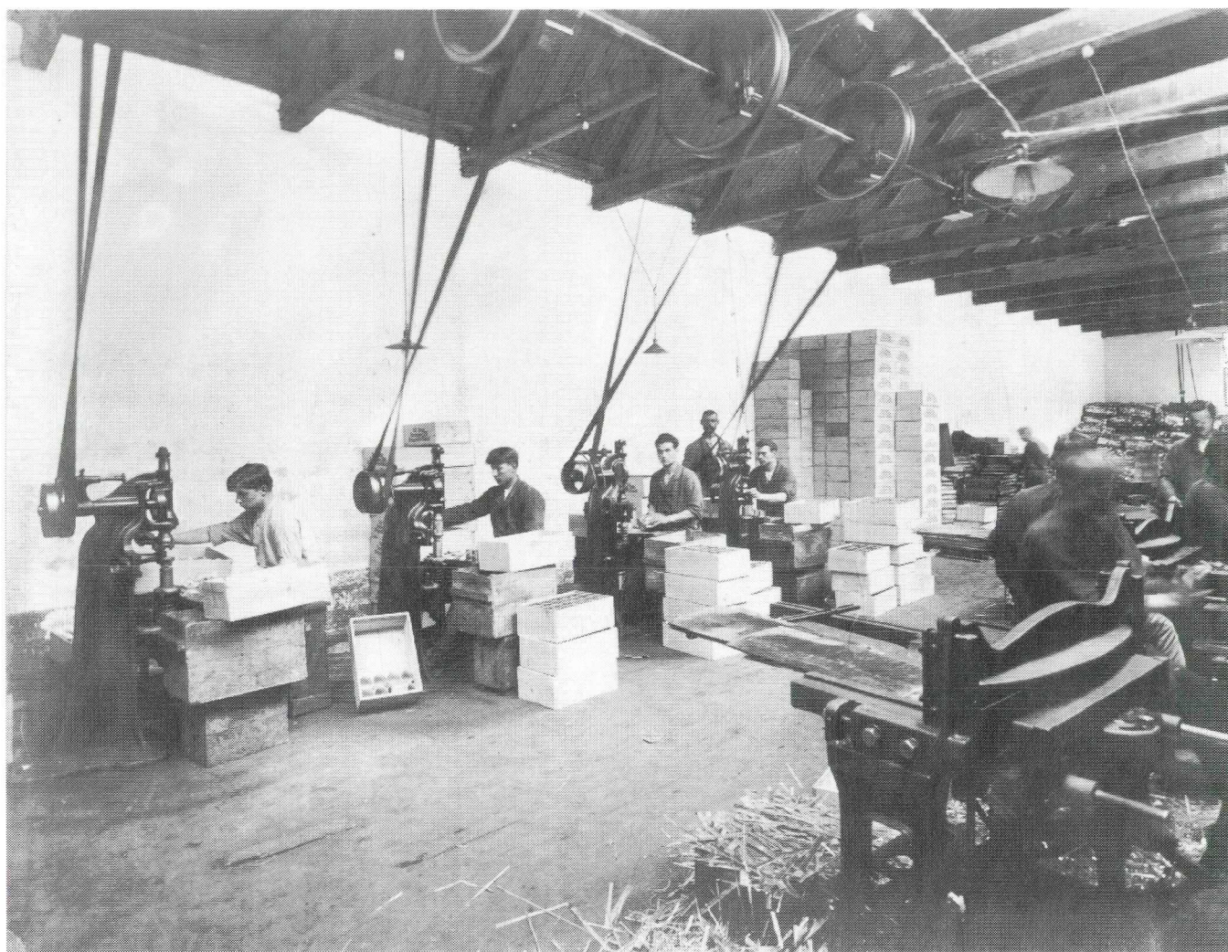
Afb. 4. De blikjesmakerij. In deze afdeling werden de condensblikjes in eigen beheer gemaakt. We zien twee bliksnijders (rechts) en vier felsmachines staan. De blikresten van het snijden zien we op de voorgrond liggen. De machinaal gestanste bodems werden met een machine op de rompen gefelst. Alle machines werden toen nog (voor 1924) met drijfriemen aangedreven. Bij de laatste felsmachine staat de afdelingsbaas Tinus Dolman.
