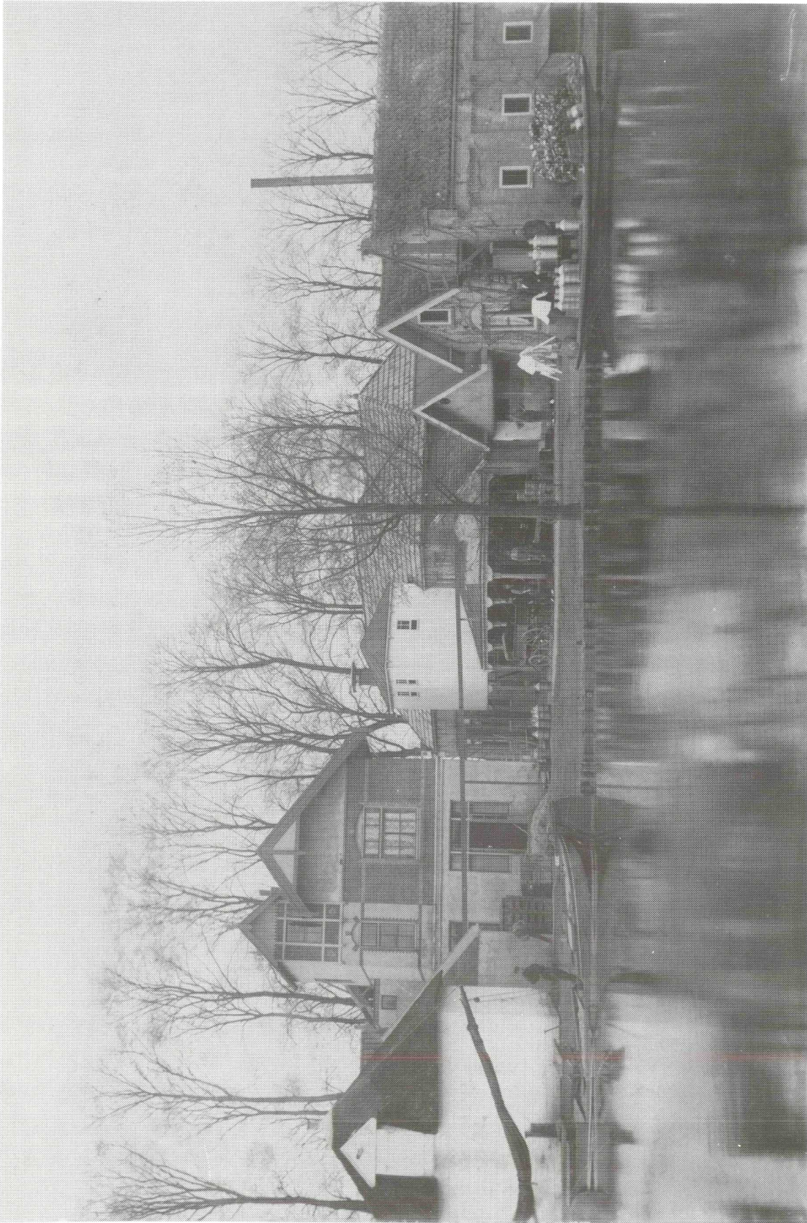
Afb. 4. De zuivelfabriek Insulinde omstreeks 1900. Links het ijspakhuis; rechts daarvan het kantoor. Achter de boom aan de Vechtoever de verhoogde vloer waar de met paardewagens aangevoerde melkbussen konden worden afgeladen; rechts worden melkbussen aangevoerd per boerenschouw. Daarachter een droogtrek, waarop doeken hangen die gebruikt werden bij de kaasfabricage. De hoge fabrieksschoorsteen aan de oever van de Vecht is er nog niet.
