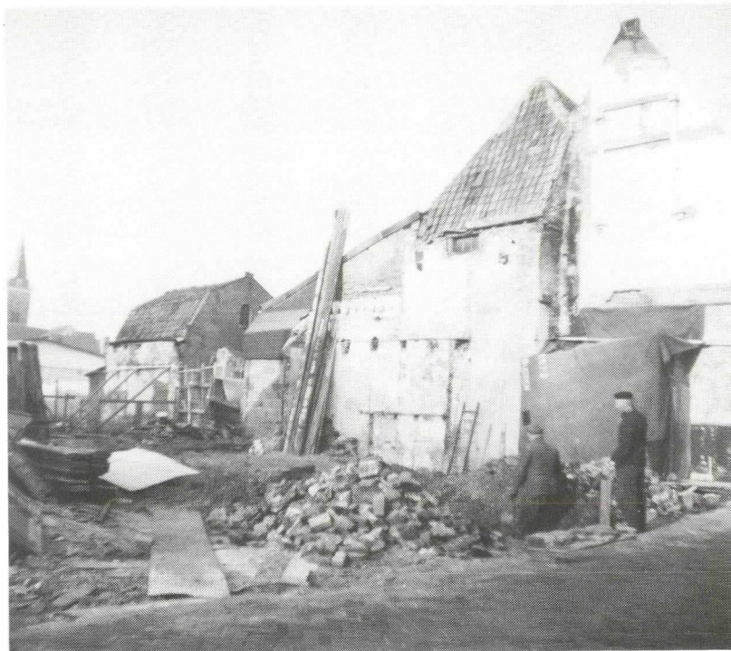
Afb. 3. De laatste huizen aan de Koekenbuurt (nrs. 13, 11 en 27) werden in december 1963 gesloopt. Gemeentewerklieden verwijderden de fundering. (Foto mevr. A.F. de Bruin, Breukelen.)
