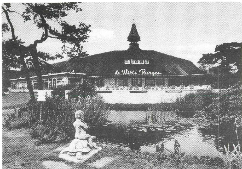
Recente opname van "De Witte Bergen"
