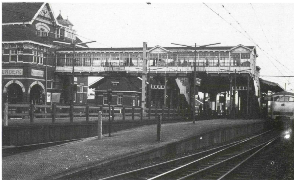
In 1976 verkeert de loopbrug nagenoeg in de originele staat, zij het met veel gebroken ruitjes. Niet veel later zou de brug bij een renovatie worden voorzien van minder verfijnd glaswerk. Foto: collectie R. Hamoen.
