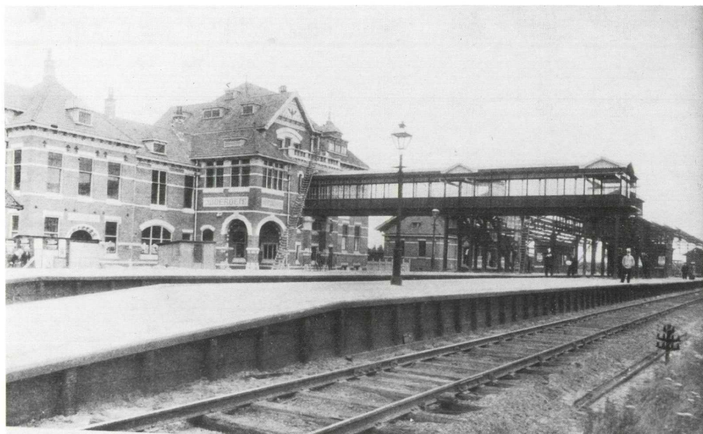
Het station van De Jong tijdens de bouw.
