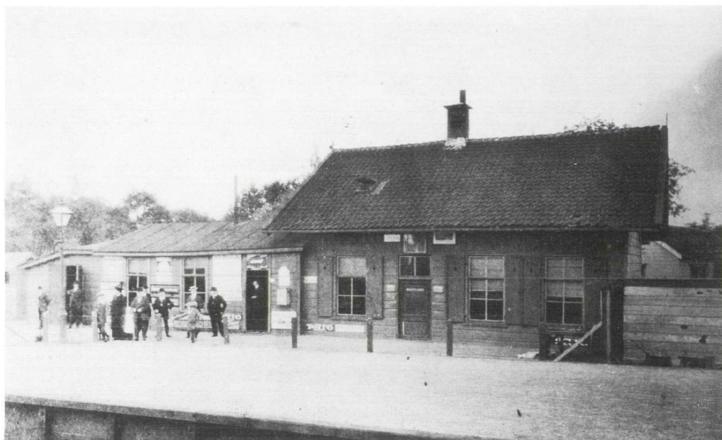
De verbouwde directiekeet van de NRS in gebruik als station, circa 1910. Links het later aangebouwde goederenloodsje.
