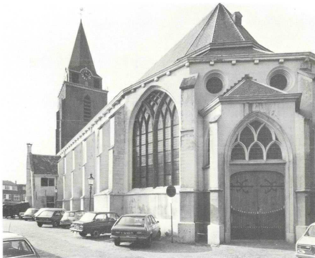
Zuideringangskapel vóór de restauratie, gezien vanuit het zuid-oosten. Foto: Rijksdienst voor de Monumentenzorg, Zeist.
