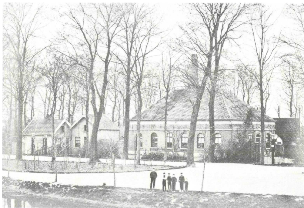
Gasfabriek te Woerden, 1873 (Coll. gemeente-archief Woerden)
