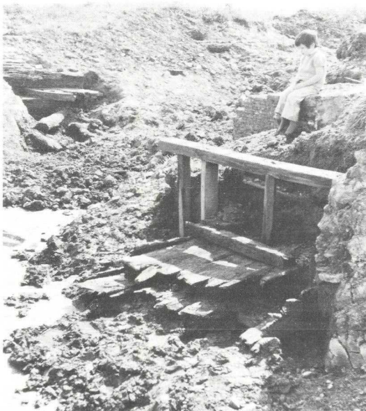
Waterloopkonstrukties van de Oosteindermolen - drie vloerniveaus.
