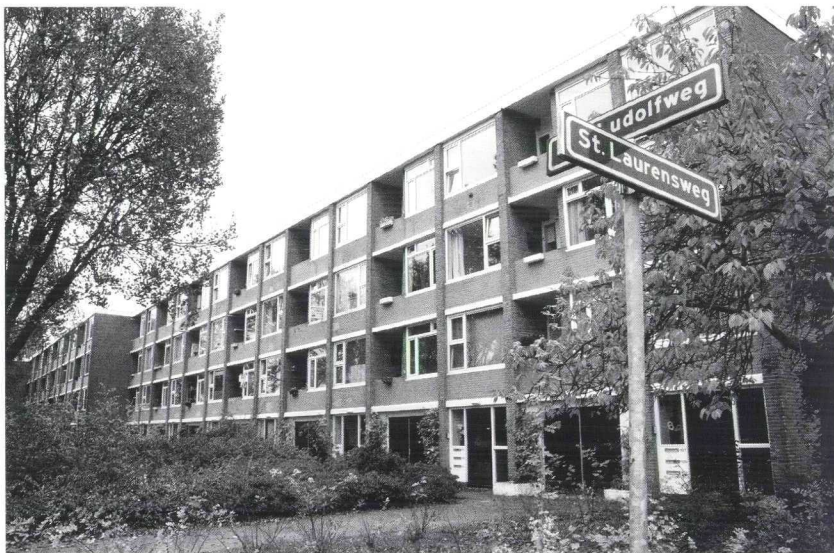
Flats aan de Abt Ludolfweg 1-107 in De Bilt met inpandige balkons of loggia's. (Foto Rob Herber 2007)
